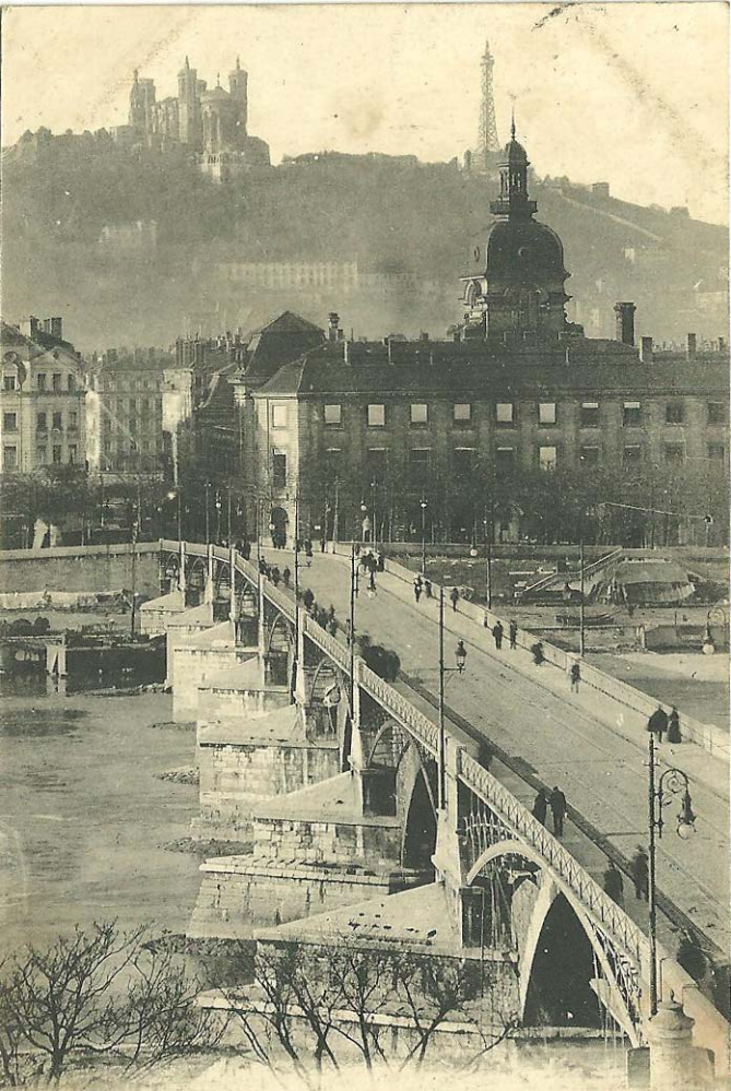
279. LYON — Pont de la Guillotière et Fourvière — E.R.
