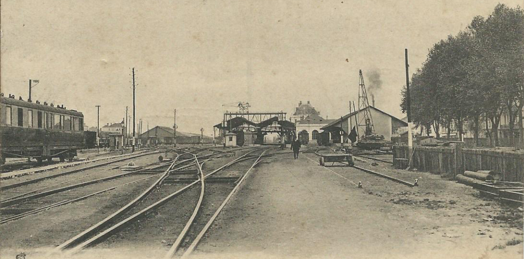
840. - ROANNE. - Vue intérieure de la Gare
